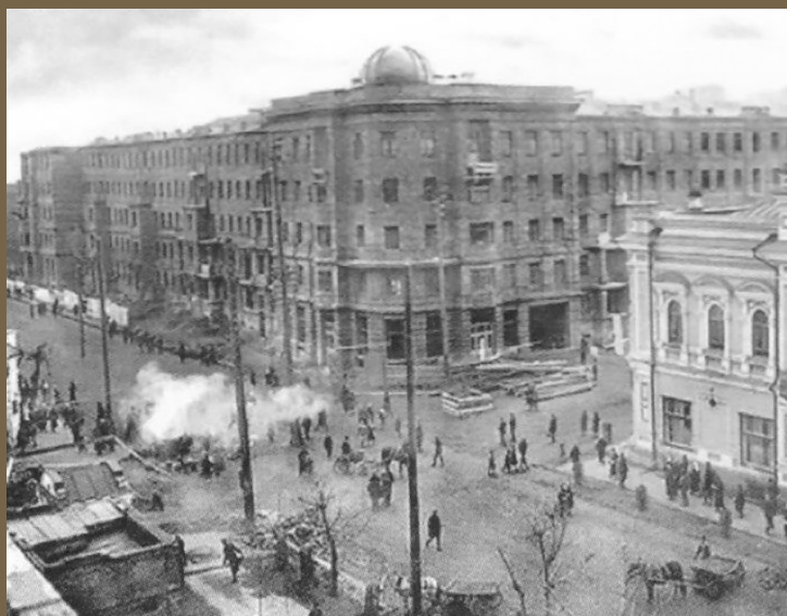
Рис. 5. Строительство Красноярского медицинского института в 1941 году Fig. 5. Construction of the Krasnoyarsk Medical Institute in 1941
